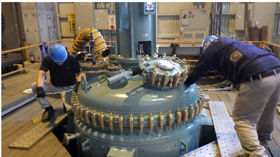
トルクレンチによる増締め例
